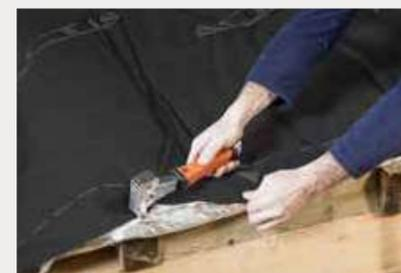
■ En périphérie de l'isolation, réaliser un retour d'isolant de 50 mm au minimum sur lui-même.
