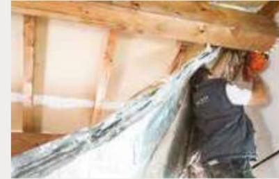
← **Agraffer la première couche du BOOST'R HYBRID<sup>3</sup> (face noire côté froid)** sur une extrémité puis le fixer en crémaillère entre chevrons avec l'accessoire ISOCLIP. L'ISOCLIP permet une fixation rapide par clouage, en assurant facilement la lame d'air lors de la pose en crémaillère et en utilisant judicieusement l'espace entre chevrons.
