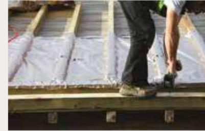
■ **Dérouler horizontalement le TRISO HYBRID<sup>3</sup>** avec la languette débordante adhésive orientée vers le bas de pente. Commencer la pose en partant de la sablière vers le faitage.
