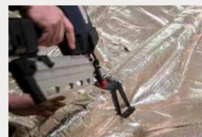
← Installer l'isolant Triso Hybrid<sup>®</sup> à l'horizontale, languette débordante adhésive orientée côté sablière, le fixer avec l'accessoire ISOCLIP.
