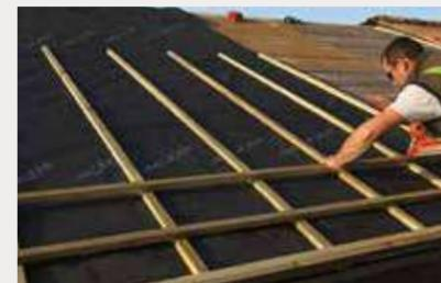
← Fixer des contre-liteaux de section 40x40 mm minimum au droit des chevrons puis fixer perpendiculairement des liteaux 20x27 mm avec un écartement compatible avec la couverture choisie.
