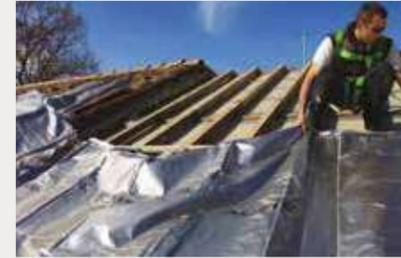
← Dérouler l'isolant **Triso Hybrid<sup>3</sup>** horizontalement sur les chevrons en prenant soin d'orienter la languette adhésive en direction de la sablière et l'agrafer en respectant les règles essentielles de mise en œuvre. Commencer la pose en partant de la sablière et en remontant jusqu'au faîtage.
