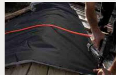
← Poser horizontalement le deuxième lé d'isolant **Boost'R Hybrid<sup>3</sup>** en réalisant la jonction des lés grâce à la languette débordante adhésive intégrée, de manière à garantir la continuité de l'isolation et de l'étanchéité. Bien maroufler.
