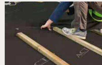
← **Reproduire les opérations précédentes** en assurant la continuité de l'isolation et de l'étanchéité à l'eau et à l'air jusqu'au faîtage.
