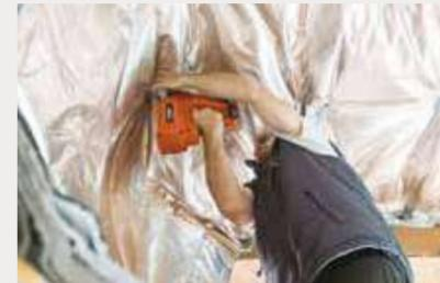
← **Une fois l'isolant Boost'R Hybrid<sup>3</sup> fixé côté mur**, continuer la fixation dans la longueur de la travée à l'aide de l'ISOCLIP vers le mur opposé. **IMPORTANT** : progresser, de chevrons en chevrons. Prévoir 40 à 50 cm d'espace entre chaque ISOCLIP.
