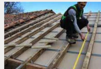
← Au préalable, retirer l'isolation thermique existante si l'épaisseur excède 10 cm ou si elle est en mauvais état.
