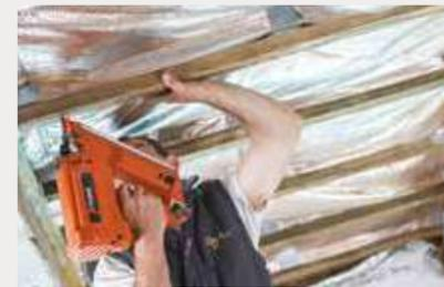
← **Mettre en place sur les pannes les liteaux 60 x 40**, pour réserver une lame d'air de 20 mm.
