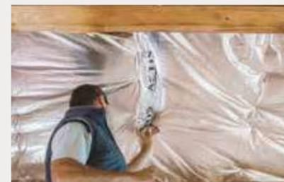
■ Fixer ensuite l'isolant **Triso Hybrid<sup>3</sup>** sur les contre-liteaux, toujours en partant d'un mur vers le mur opposé, de liteau en liteau, avec une pose tendue pour assurer la lame d'air non ventilée de 20 mm entre le **Boost'R Hybrid<sup>3</sup>** et le **Triso Hybrid<sup>3</sup>**.
