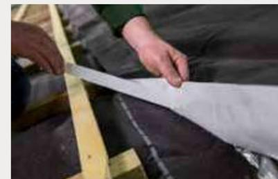
■ **Poser horizontalement le deuxième lé d'isolant BOOST'R HYBRID<sup>3</sup>** avec un recouvrement de 10 cm minimum sur le premier lé.
