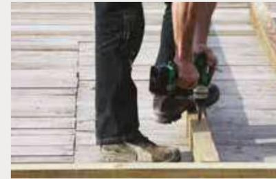
← **Fixer mécaniquement une ossature bois** (chevrons de 8 x 6 minimum ou double tasseau) dans la structure bois existante et au travers de la volige, y compris en périphérie pour assurer l'étanchéité à l'air de la toiture.
