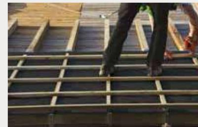
← **Poser ensuite les liteaux support de couverture** perpendiculairement aux chevrons, avec un écartement adapté à la couverture choisie (tuiles, ardoises, etc.).
