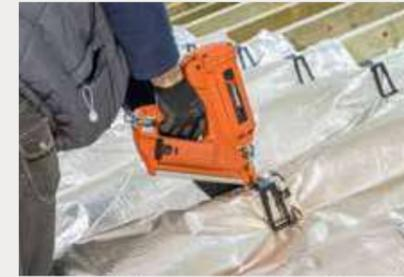
■ **Poser l'isolant Triso Hybrid<sup>3</sup>** horizontalement, languette débordante adhésive orientée vers le bas de pente. Commencer la pose en partant de la sablière et en remontant jusqu'au faîtage.
