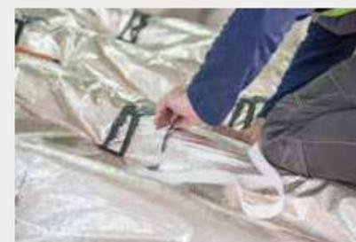
■ Aux jonctions des lés, les superposer et les fixer avec l'ISOCLIP au cloueur.
