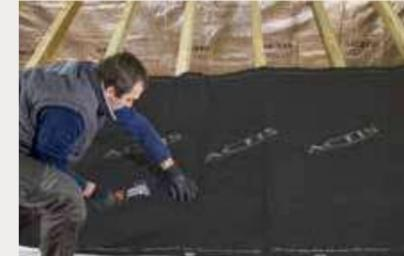
■ **Dérouler à l'horizontale l'isolant Boost'R Hybrid<sup>3</sup>**, languette débordante adhésive orientée vers le bas de pente, de la sablière et en prenant soin de le décaler d'au moins 30 cm par rapport au 1<sup>er</sup> lé d'isolant Triso Hybrid<sup>3</sup>.
