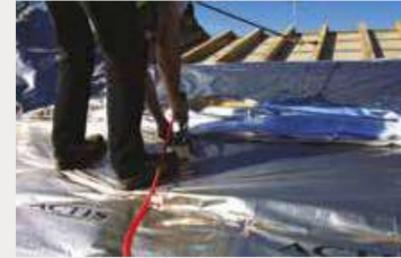
← Poser horizontalement le deuxième lé avec un recouvrement de 5 cm minimum sur le 1<sup>er</sup> lé pour la reprise en longueur.
