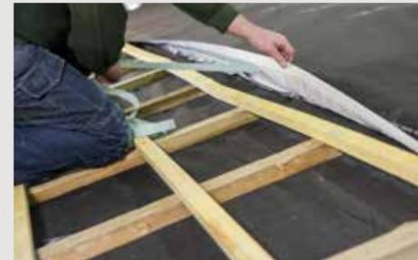
← Dérouler le 2<sup>ème</sup> lé d'isolant comme dans l'étape 1 et assurer la jonction longitudinale des deux lés grâce à la languette débordante adhésive intégrée. Procéder à un léger recouvrement pour garantir la continuité de l'isolation et de l'étanchéité. Utiliser l'adhésif ISODHESIF LAINE pour les jonctions latérales des lés.
