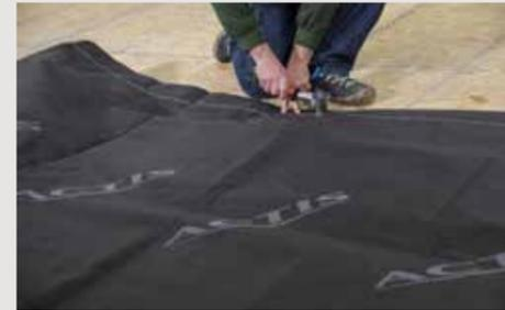
← Ouvrir la sache à l'aide du cutter ACTIS pour ne pas couper l'isolant et dérouler horizontalement le BOOST'R HYBRID<sup>3</sup> directement sur la volige en commençant par le bas de pente.
